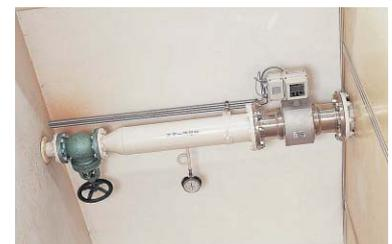
圧縮空気メイン配管の流量計測を担うCML
