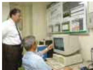
コンプレッサーエアアの監視・制御
