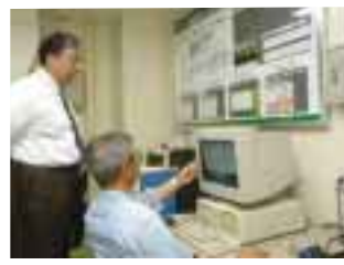
コンプレッサーエアーの監視・制御
