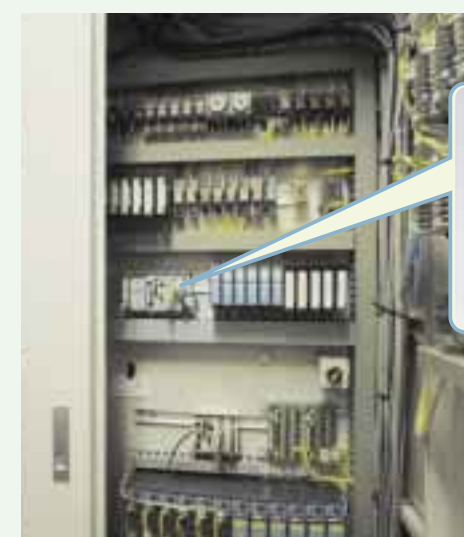
計測標準室に設置した制御盤
