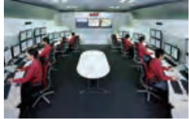
ビルの総合管理・保安を行う遠隔監視センター
