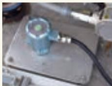
供給エリア内約4,000カ所の地区ガバナ内に設置された地震センサ SES70。
