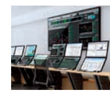
監視制御システム 設備の規模に応じ、安全かつ安定した生産を実現する可用性の高い運転監視制御を支援。
