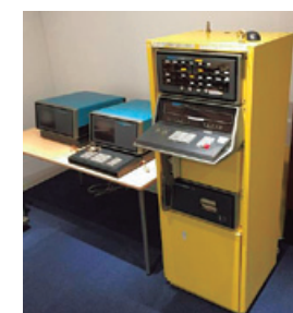
1980年代の空調制御システム
