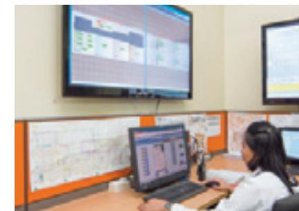
第1期拡張プロジェクトであるスカイトワーエリアの設備を監視・制御するsavic-net FX。監視・制御用の通信をソレア リゾート&カジノ内のイントラネットを活用することでネットワーク工事の負荷軽減を図ったほか、将来の拡張性にも備えることができました。
