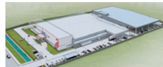
▲ タイ工場 新棟建設（2017年竣工）
