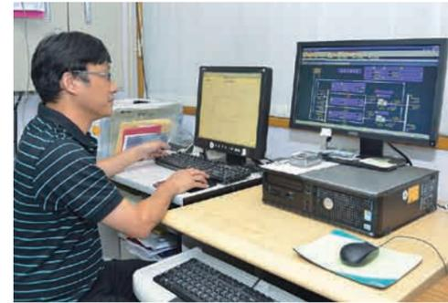
设置在图书馆地下一层的监控室内的 savic-net FX (右) 与 EDS (左) 监控终端。操作人员可以监视和控制新引进的 HVAC 设备的运行，掌握能耗趋势。
