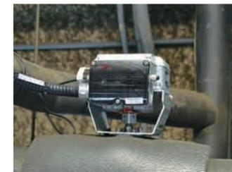
安装在 HVAC 的冷水盘管上的 ACTIVAL PLUS 电动二通阀。这种阀门集控制阀、流量计、压力计以及温度计的功能于一体，可以显著降低成本。
