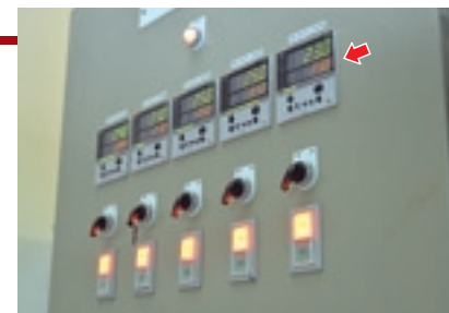
数字显示调节器。根据温度传感器等测量的数值来控制水温。
