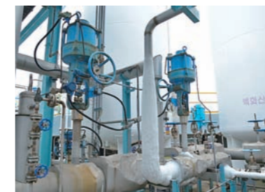
在空气分离过程中使用的低温阀“先导型单座调节阀 HTS”。是对零下190℃的液氧进行控制的设备，要求具有持久的耐超低温性能。由于处理的是超低温液体，所以管道上出现结霜。
