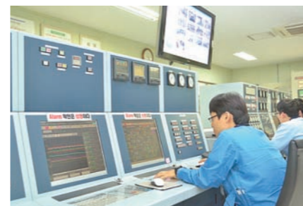
中央监视室中安装的Harmonas-DEO监控系统。平时最少3个人便可完成对第1和第2装置的监视工作。
