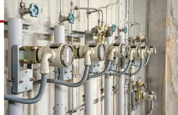
压差/压力变送器 DSTJ™3000 Ace\*。计量温水主管及冷水主管的压力。
