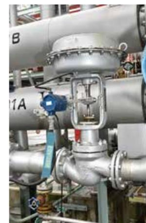
苯乙烯单体生产设备上运行的智能阀门定位器和顶部导向型单座调节阀。定位器将阀门的运行数据发送给调节阀维护支持系统，可迅速检测到异常征兆。
