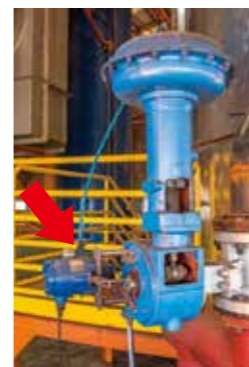
在熬糖浆使其结晶(煎糖、结晶)的工艺中，安装在糖浆流量控制阀上的阿自倍尔智能阀门定位器。根据阀门的形状使用不同的安装板进行安装。
