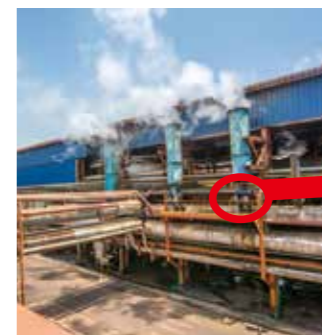
安装在蒸汽释放阀上的阿自倍尔智能阀门定位器。
