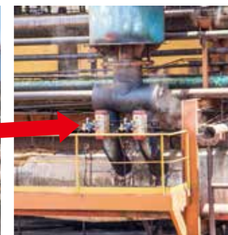
安装在蒸汽释放阀上的阿自倍尔智能阀门定位器。
