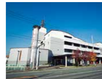
消防局仓敷消防署综合办公大楼（左）和儿岛消防署（右）。每月进行一次巡检和远程监控。
