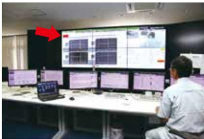
在净水管理中心内的大型显示屏上显示重要过程变量变化监视系统的监视画面，可以随时确认状态。另外，发生异常时，监视器上会显示警报，引起员工注意。
