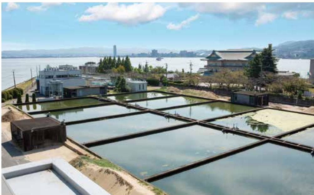
在负责自来水相关设备管理运营的大津市企业局净水管理中心，为了持续稳定地供应市民生活中不可缺少的水，引进了可以预测近期供水池水位变化的重要过程变量变化监视系统。在发生了以供水池的水泵停止运转等为代表的突发事件时，能够迅速采取适当的措施，而且也有助于提供品质稳定的自来水。
