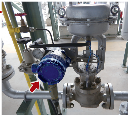
安装在阀门上的智能阀门定位器与InnovativeField Organizer之间进行HART通讯，将现场工作设备运转状况可视化。
