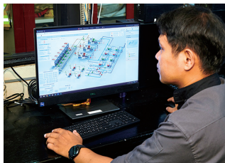
作为BEMS新引进的savic-net G5的监视画面。可以通过简单易懂的图表来确认设备的运行状况。
