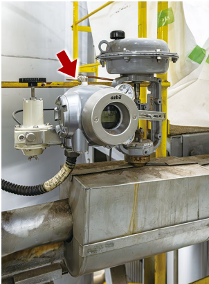
在 Valstaff 的画面上可以通过图表确认主蒸汽温度调节阀的粘滑现象*5 诊断参数
