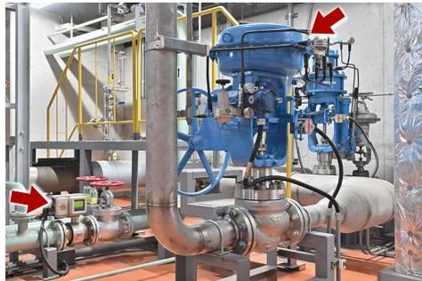
调节氧气压缩机压力的顶部导向型单座调节阀 (右) 和测量冷却水流量的电磁流量计 MagneW™ FLEX+ (左)。
