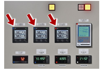
安装在用户侧接收设备计量盘上的图形形式调节器 型号C7G。用于调节冷水和蒸汽的流量、热量及压力
