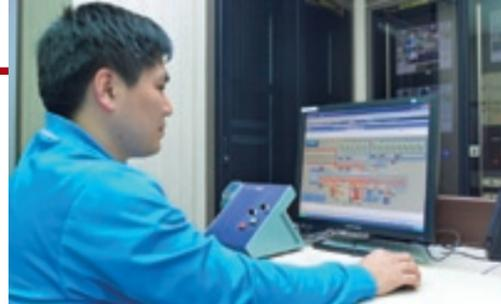
安装在中央监控室中的 savic-net FX 监控终端。实现了对于展示水箱中水温等的集中监控。
