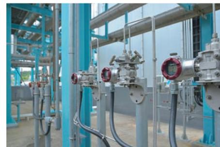
在气体生产的空气分离过程中使用的差压/压力变送器“AT9000 Advanced Transmitter SuperAce™”。
