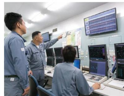
对环己酮生产装置进行集中监视的仪器室。在APS5000的监控终端上方安装了65英寸的大型显示屏。平时显示APS5000等的监视画面,发生警报时会强制切换到ACTMoS的监视画面。发生警报时,现场所有人都可以通过画面来共享信息,并共同进行处理。
