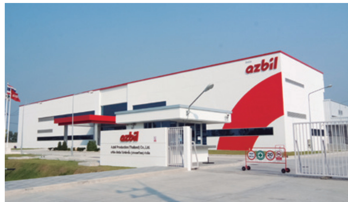
在泰国中部春武里府的 Amata Nakorn 工业园区建成的 Azbil Production (Thailand) 的新工厂。
