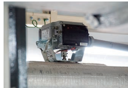
控制空调用冷水流量的带有流量测量控制功能的电动二通阀ACTIVAL。
