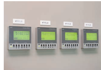
用于监视4台冷冻机的工作状况的热量计。
