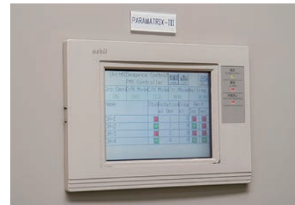
进行冷冻机的最佳运行控制的PARAMATRIX-III。
