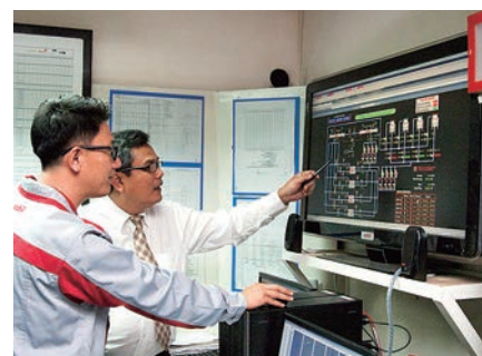
中央监控室中作为BEMS引进的savic-net FX。可以一目了然地确认热源设备的运行状况和能源使用量。
