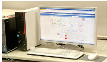
安装在中央监控室内的savic-net FX2,实现收藏库及陈列室等大学美术馆内各区域的温湿度及各设备的能源使用状况可视化。运用数据也在累积。
