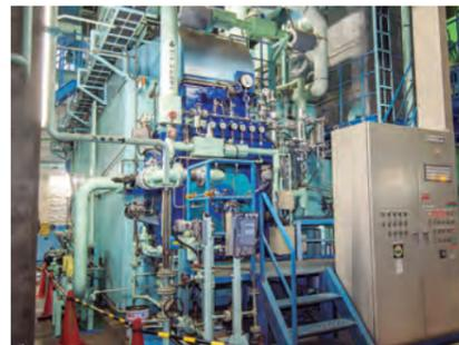
双锅筒水管式蒸汽锅炉。
