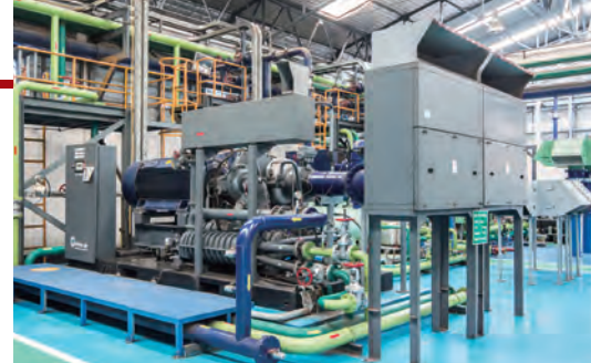
向SKIC的整个Wangsala工厂供给空气的压缩机群。
