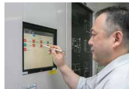
采用可节省安装空间的中央监控系统——壁挂式BA系统。
