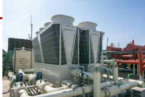
安装在佐仓市立美术馆屋顶上的空冷式热泵冷冻机(左)和热水器(右)。在此次的ESCO事业中更换为高效设备。
