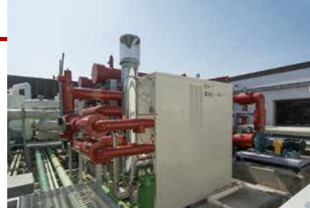
安装在佐仓市立美术馆屋顶上的空冷式热泵冷冻机(左)和热水器(右)。在此次的ESCO事业中更换为高效设备。
