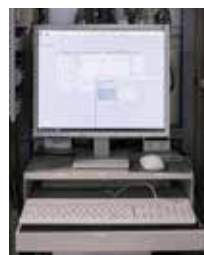
安装在空调控制盘内的 savic-net™FX mini。
