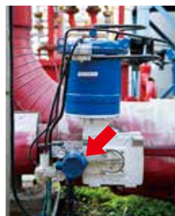
安装在用于纯碱电解设备氢压力调节的阿自倍尔阀门上的智能阀门定位器。
