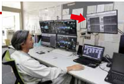
净水管理中心安装的重要过程变量变化监视系统，也可以导入其他公司的监视系统。无需设定复杂的条件，只需作为模拟数据收集的 1 个管理点即可进行预测，这一点也很方便。
