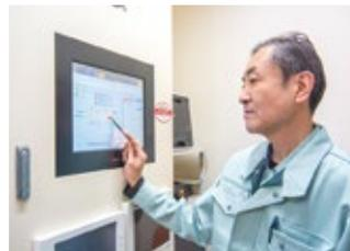
九段小学校・幼稚園の施設全体の空調を中央集中型で管理しているsavic-net FX2compact。この中央監視装置がアズビルのBOSSセンターと接続し遠隔から施設の設備の状態を監視する。
