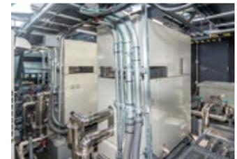
設備の運転データを解析することで運転時間の見直しを行い電力量削減につながったコージェネレーションシステム。施設の屋上に設備が設置されている。
