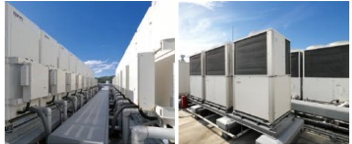
新本庁舎屋上に設置された電気式ヒートポンプ(左)とガス式ヒートポンプ(右)。電気による空調に加え、ガス空調を併用することで電力需要と電気の基本使用料を抑制することができる。
