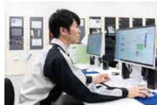
ビル内防災センターに設置されたsavic-net G5の監視端末。
