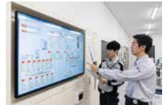
savic-net G5のサマリグラフ 受変電系統図を大型モニタ上で表示し、停電計画のチェックを行う。
