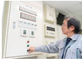
多用途型トリアージ施設に設置された操作盤。スイッチ一つで通常モード/陰圧モードの切替えができる。
