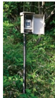
確実なデータ送信が行えるよう、電波の状況によって無線通信端末の設置場所や高さを調節している。
