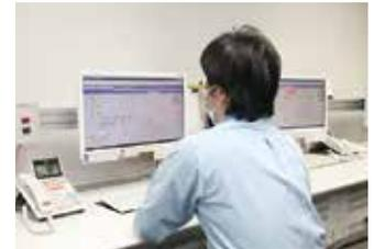
中央監視室に設置されている空調・熱源・照明などを監視制御するsavic-net FX2。セキュリティとの統合化システムとなっているが、空調などの設備の運用状況とセキュリティ関連の情報をそれぞれ別の端末で監視することができる。
