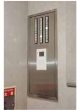
ビル1階の警備室前に設置されたエレベータ不停止解除リーダー。自社のオフィスがあるフロアが不停止状態になっている場合、テナント入居者が自分の携帯するカードでその解除を行うことができる。
