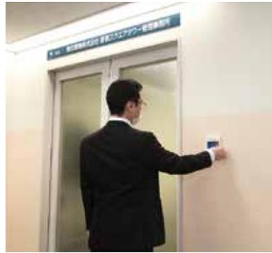
各テナントオフィスの扉の横に設置されたリーダーが非接触ICカードをかざすことで解錠し入室できる。暗証番号を加えた多要素認証の仕組みも用意しており、各テナントは運用方法の選択が可能。
