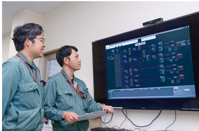
事務所の会議スペースの大型モニターではHarmonas-DEOの監視画面が常時表示されており、製造部門の責任者などは、事務所に立ち寄った際に製造状況を常に確認している。
