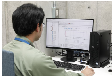
計器室に設置されたIFOのモニター画面。フィールド機器の稼働状況を現場に赴かなくても計器室から確認できる。
