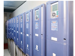
空調機に冷水・冷却水を送るためのポンプ(左)とポンプの変流量制御を行うインバータ。
