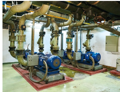
空調機に冷水・冷却水を送るためのポンプ(左)とポンプの変流量制御を行うインバータ。
