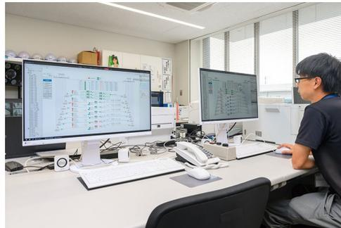
庁舎内の設備・機器を監視・制御する中央監視装置savic-net G5。熱源設備の監視画面では、直感的で見やすいグラフィックで設備の稼働状況を確認することができる。
