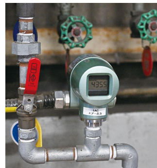
製造ラインで利用する圧縮空気の圧力を計測する圧力センサ Bravolight™
