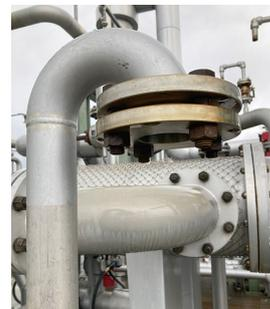
装置ベント(給気、排気口)。FSでは、ベントに取り付けられた金網のフィルタ詰まりに起因するプロセスの反応異常をオペレータより約8日前にBiG EYESが検知している
