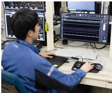
中央制御室に設置されたBiG EYESで供給ポンプの電流値を監視
