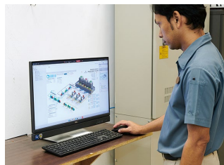
空調熱源設備の稼働状況を監視するsavic-net G5。データを収集して省エネ対策が必要な箇所を特定したり、施策実施の効果を確認することができる
