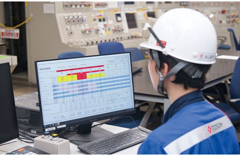
動力課の中央監視室に設置されたSORTiA-MPC監視画面
