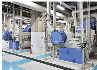
電動ターボ冷凍機。ここで作られた冷水が導管を通して需要家に供給される
