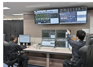
地域熱供給プラントの監視・制御を行うHarmonas-DEO。55インチの大型モニターを導入し、監視画面に加え、気象情報や防犯カメラの映像なども同一の画面に表示し、オペレータ全員が一目で状況を把握できる環境を整えた
