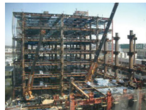
100周年の完成を目指して工事が進む藤沢新技術棟
